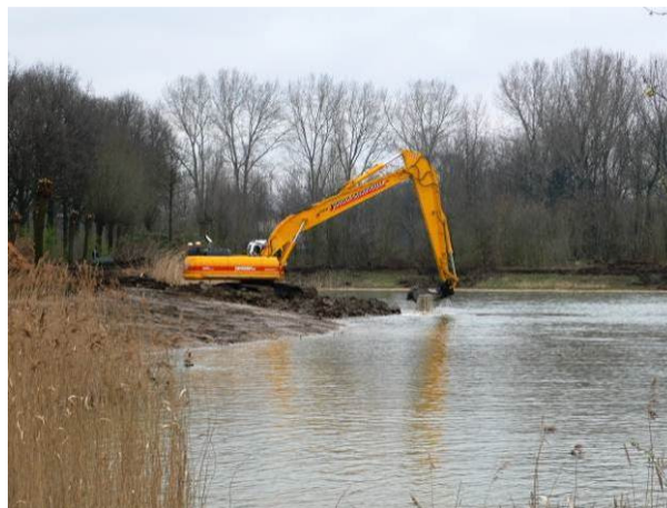
Herinrichting – afvlakken oever talud
